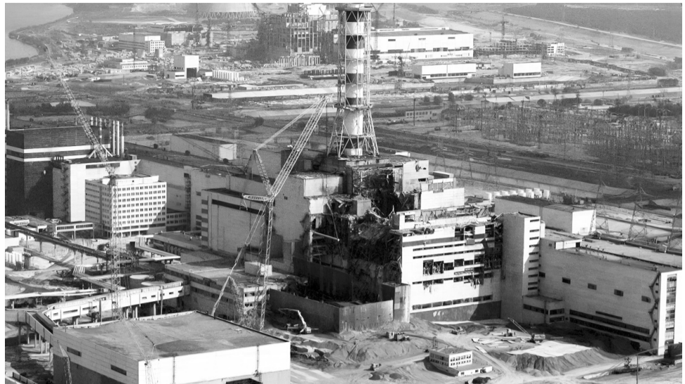
Возведение саркофага на Чернобыльской АЭС. 1986 год.
